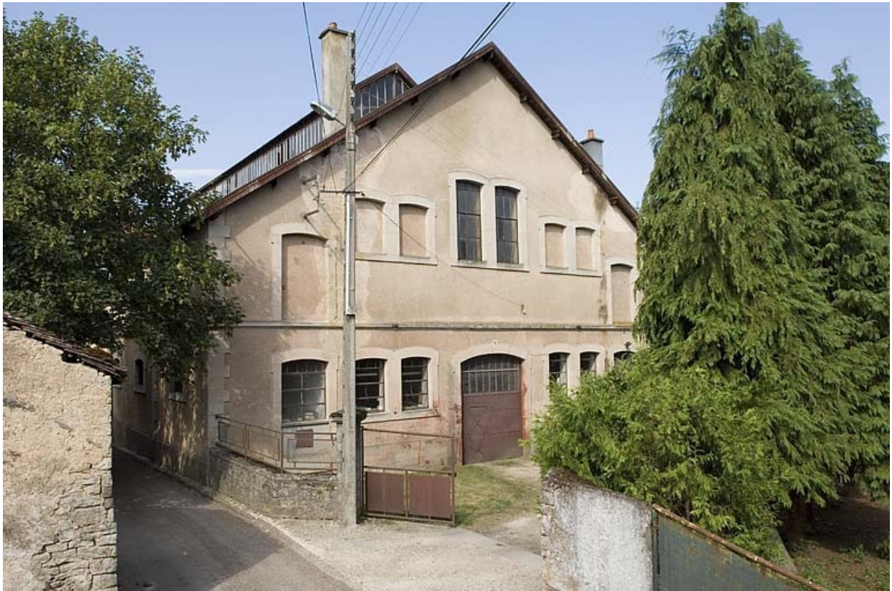
Vue sur le pignon oriental.
