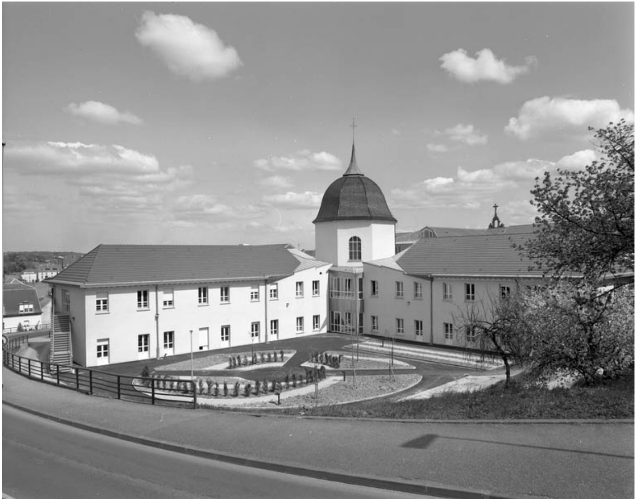
Cour à l'arrière de l'édifice : vue éloignée.
