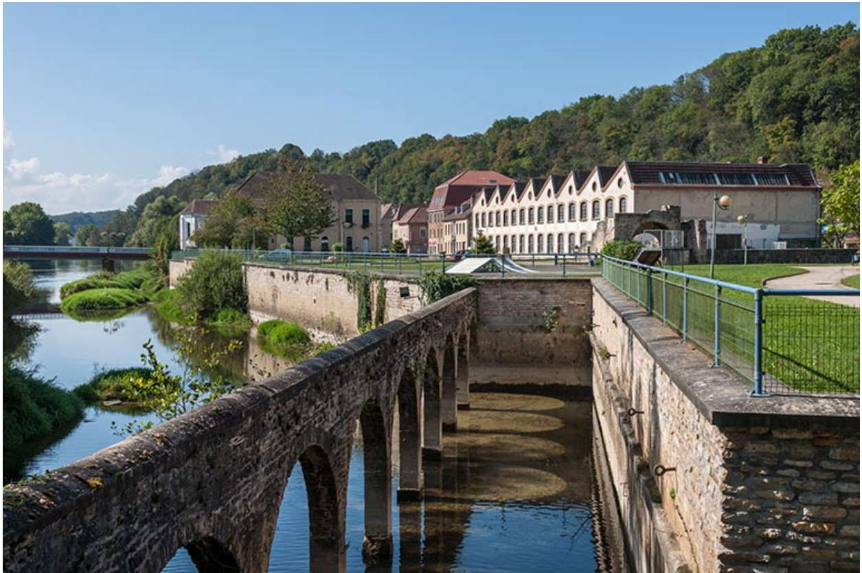
Vue d'ensemble depuis le nord du site.
