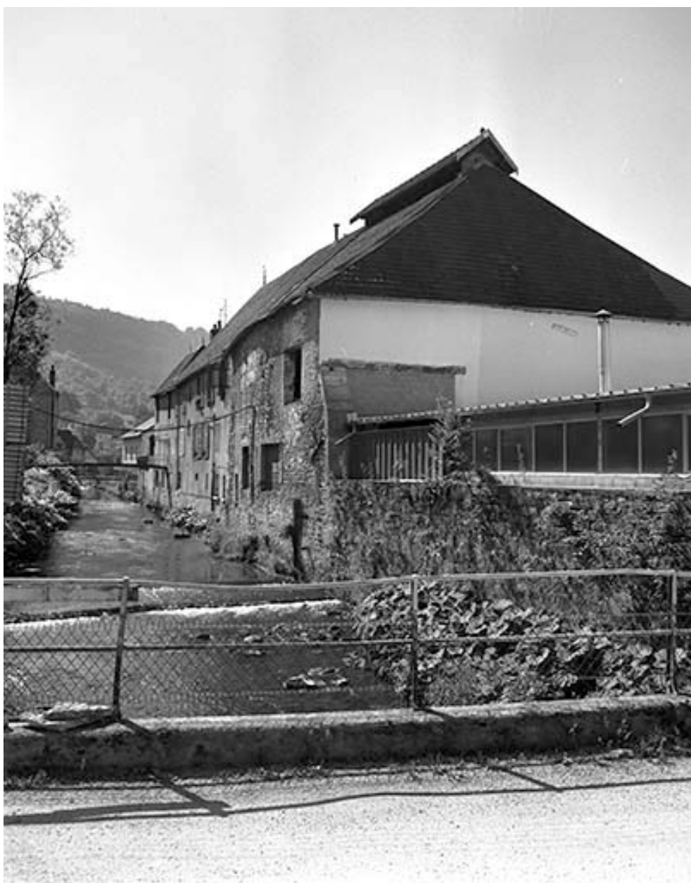
Façade postérieure de l'atelier de fabrication.
