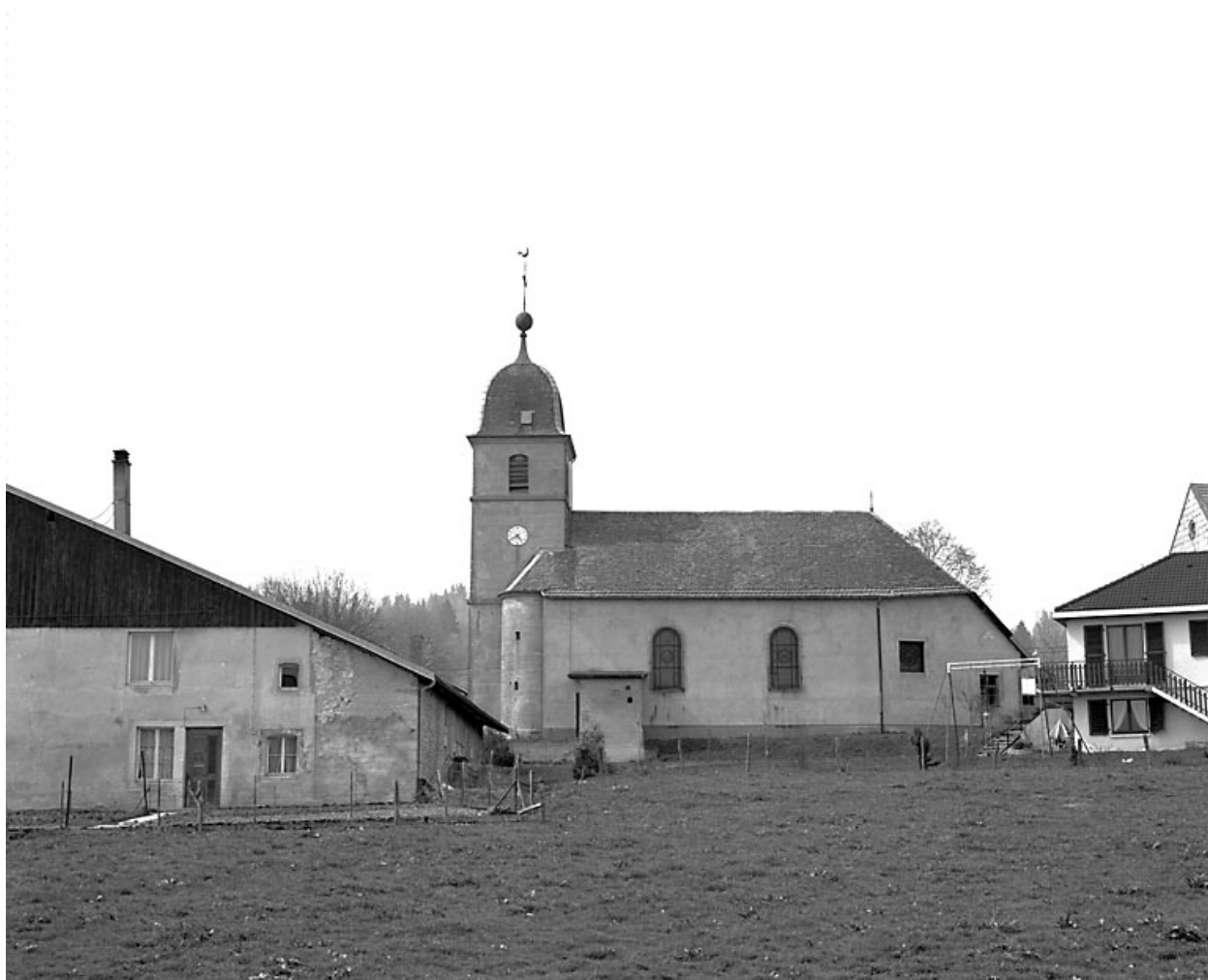
Façade latérale sud.
