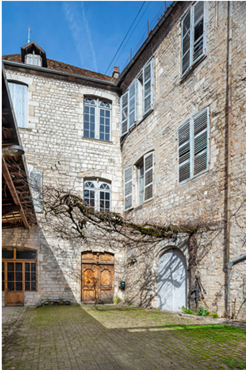
Façades est et sud depuis la cour.
