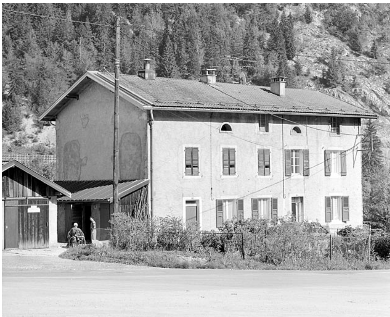
Façades antérieure et latérale gauche.
