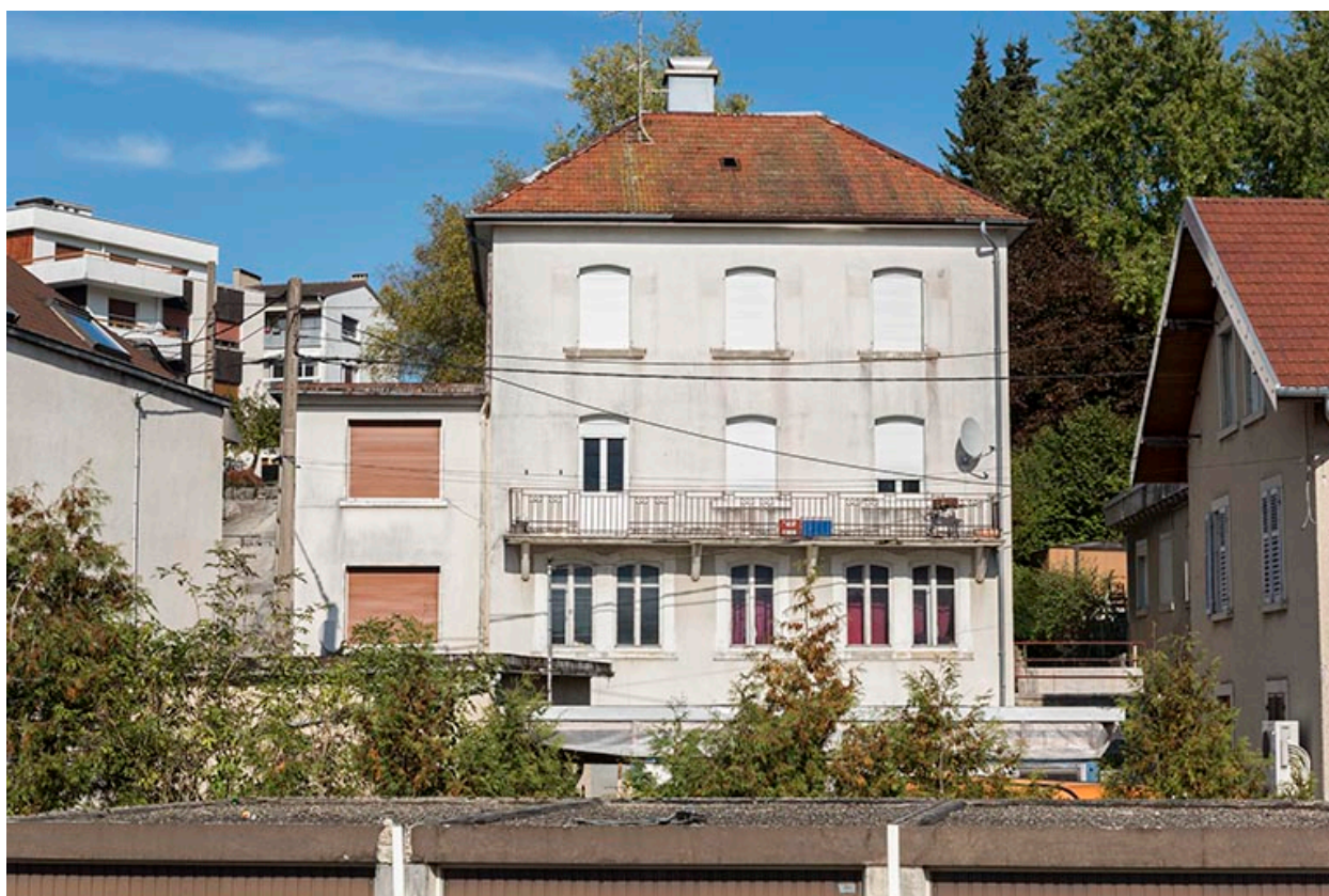
Maison : façade antérieure.
