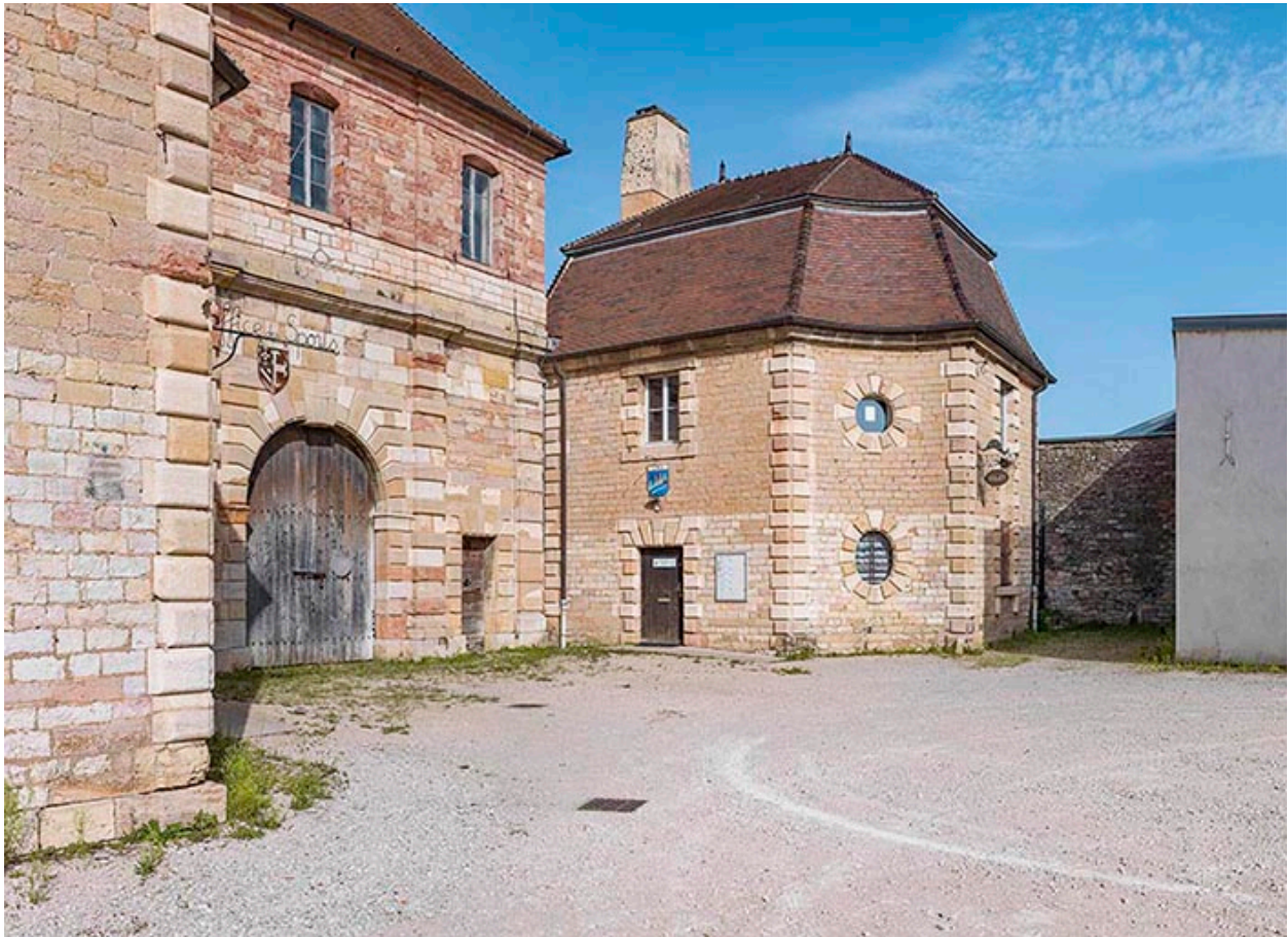
L'entrée cochère et un des pavillons.
