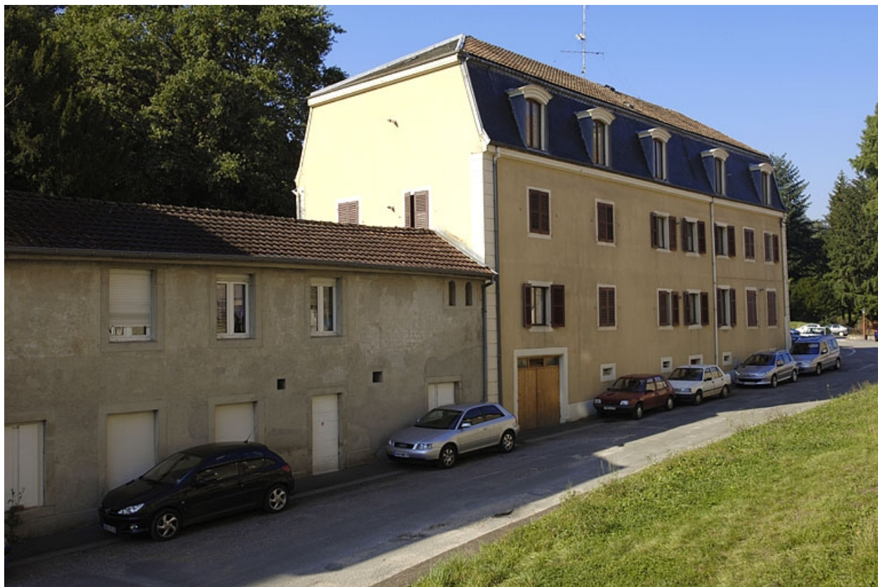
Ancien logement patronal.
