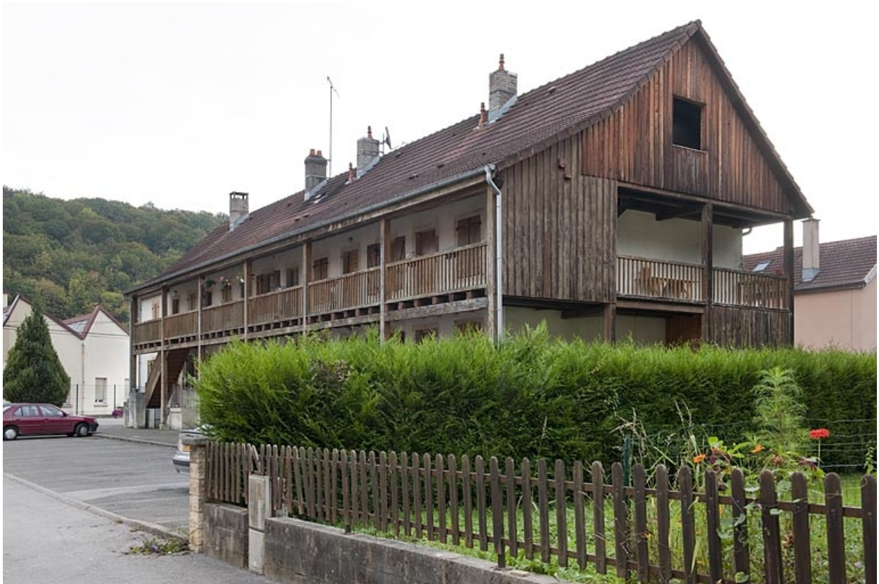
Vue de trois quarts depuis l'ouest.
