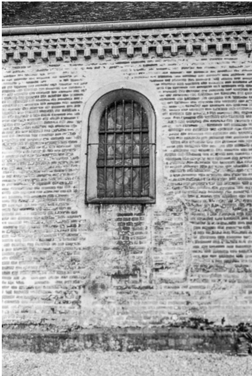
Extérieur : baie latérale.
