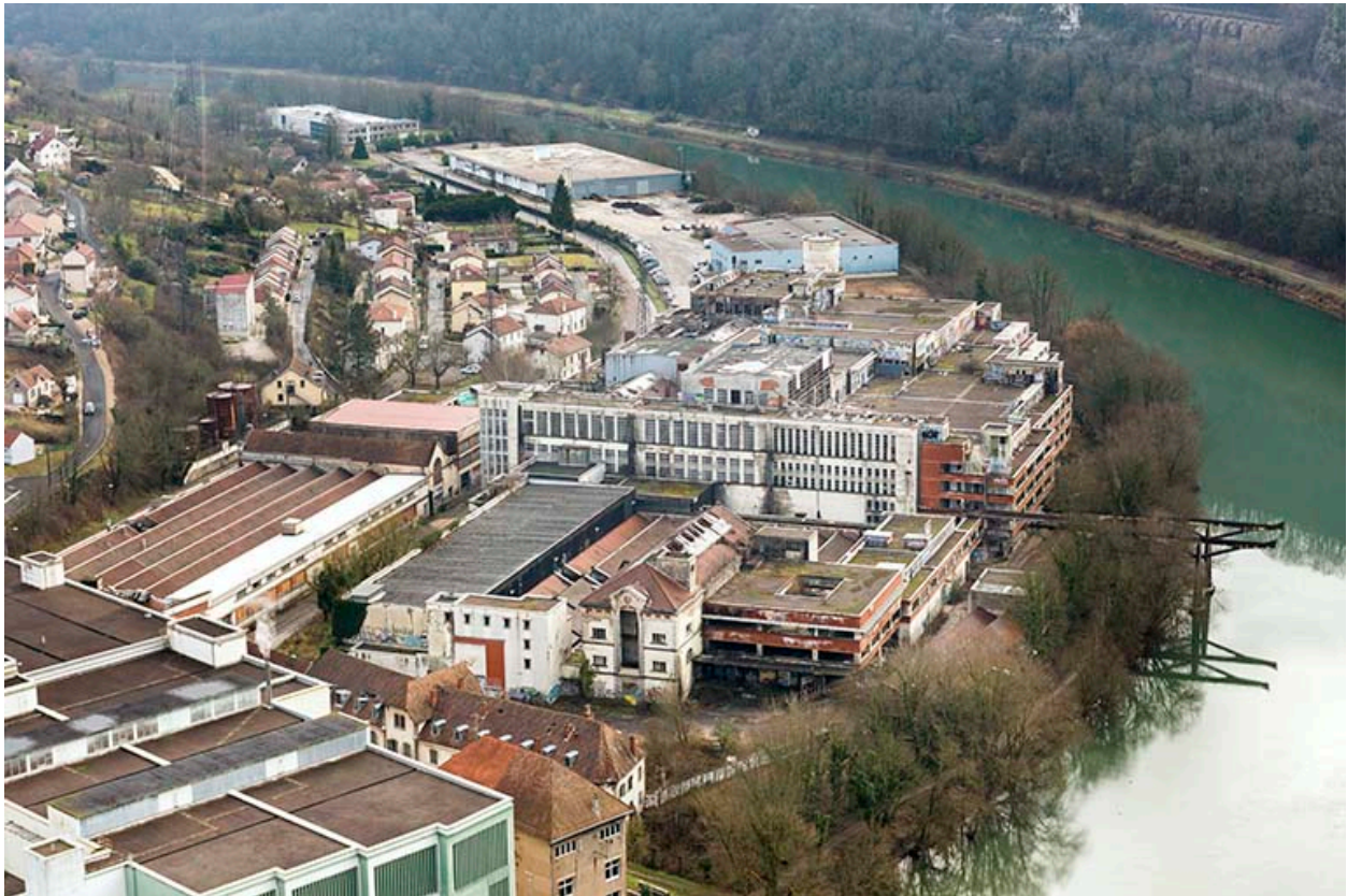
Etat en 2016. Usine A, vue de l'ouest (cadrage horizontal).
