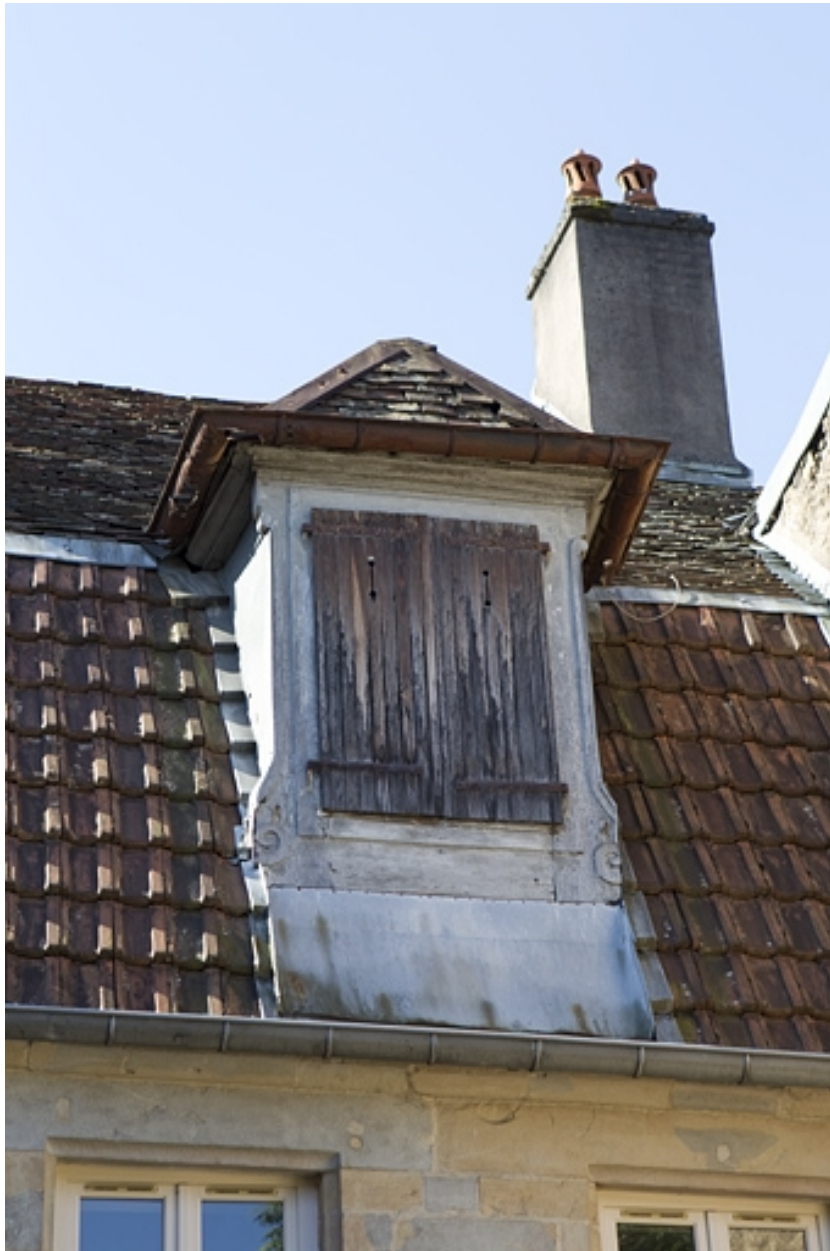
Toit du premier logis secondaire : détail d'une lucarne donnant sur la deuxième cour.
