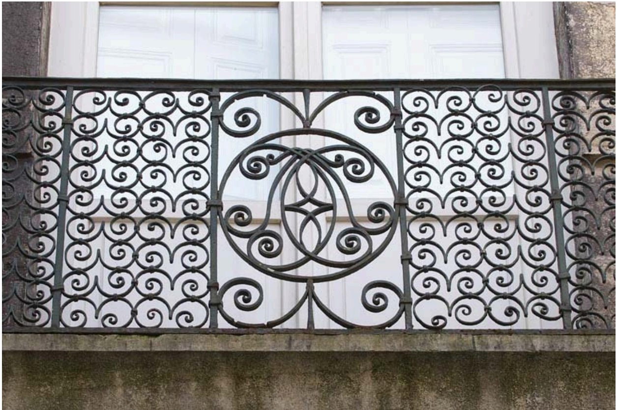
Logis principal, façade sur cour : détail de la ferronnerie d'un garde-corps.
