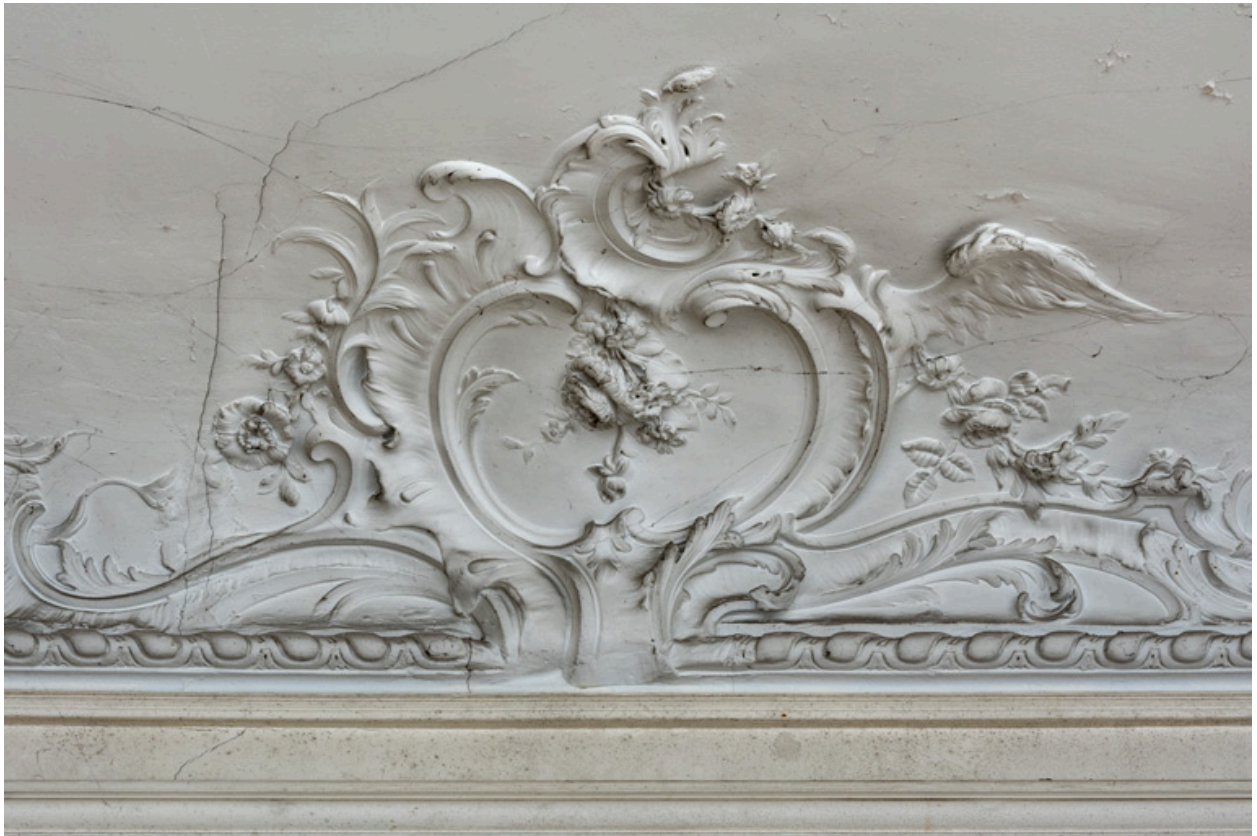
Salon du rez-de-chaussée, plafond, décor sculpté, détail : bouquet.
