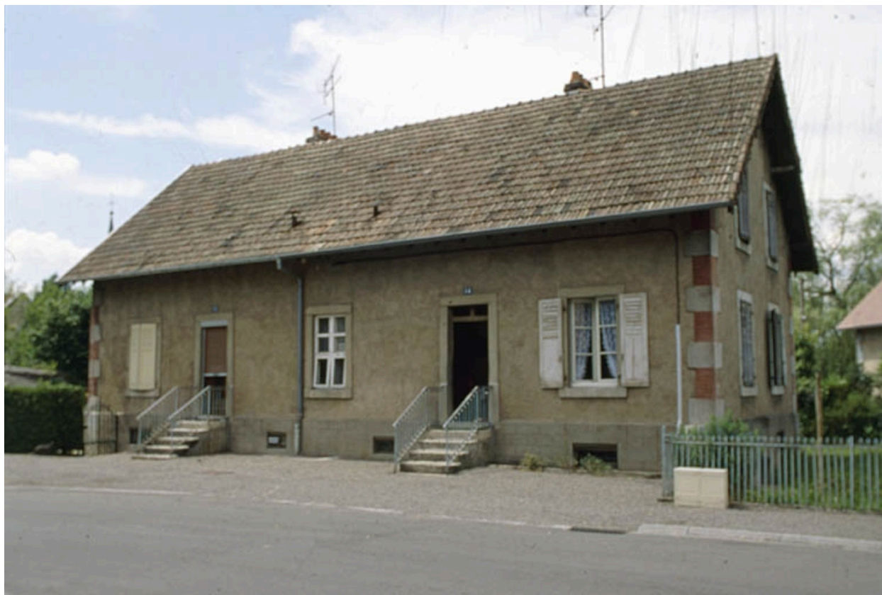
Maison à deux logements rue Kléber.
