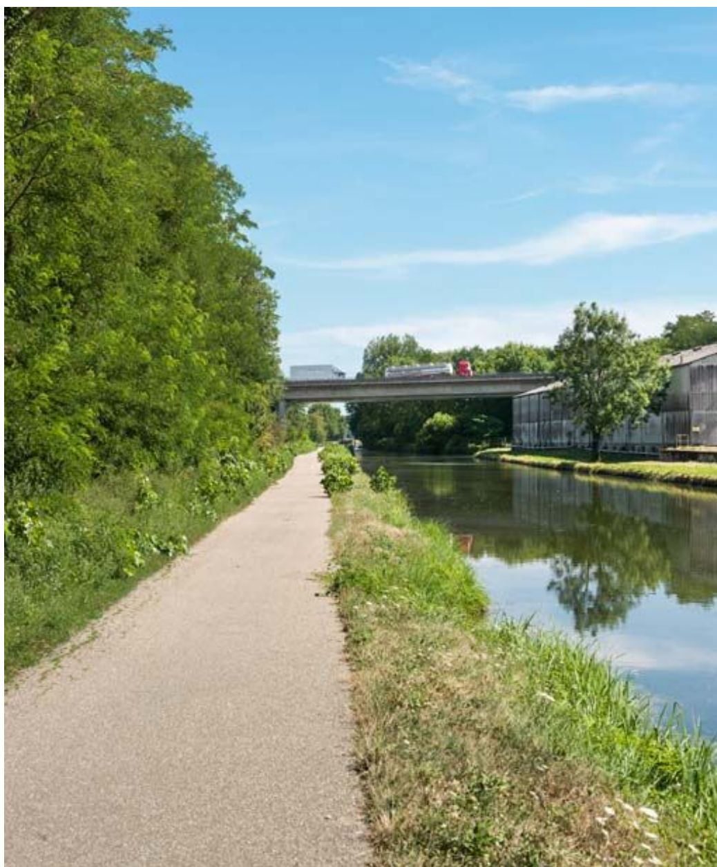
Vue d'ensemble du pont.
