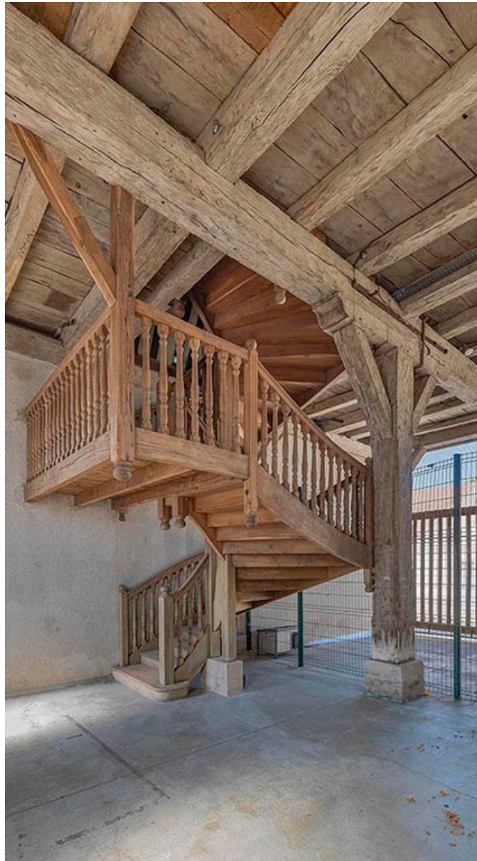
Escalier desservant l'étage supérieur du hangar.
