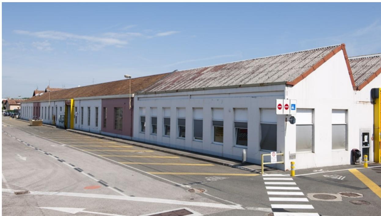
Façade sud de l'atelier des tours.
