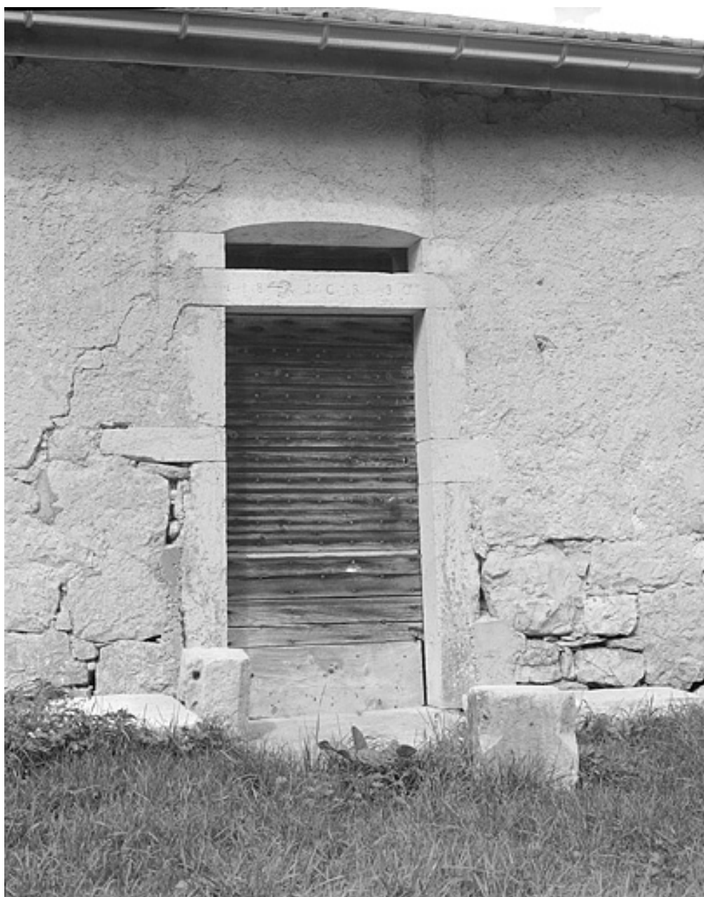
Porte du logis sur la façade antérieure.
