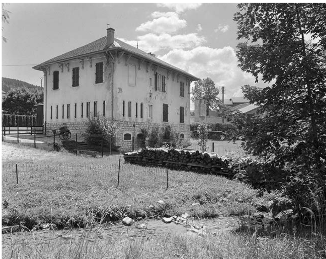
Face droite et façade postérieure vues de trois quarts.
