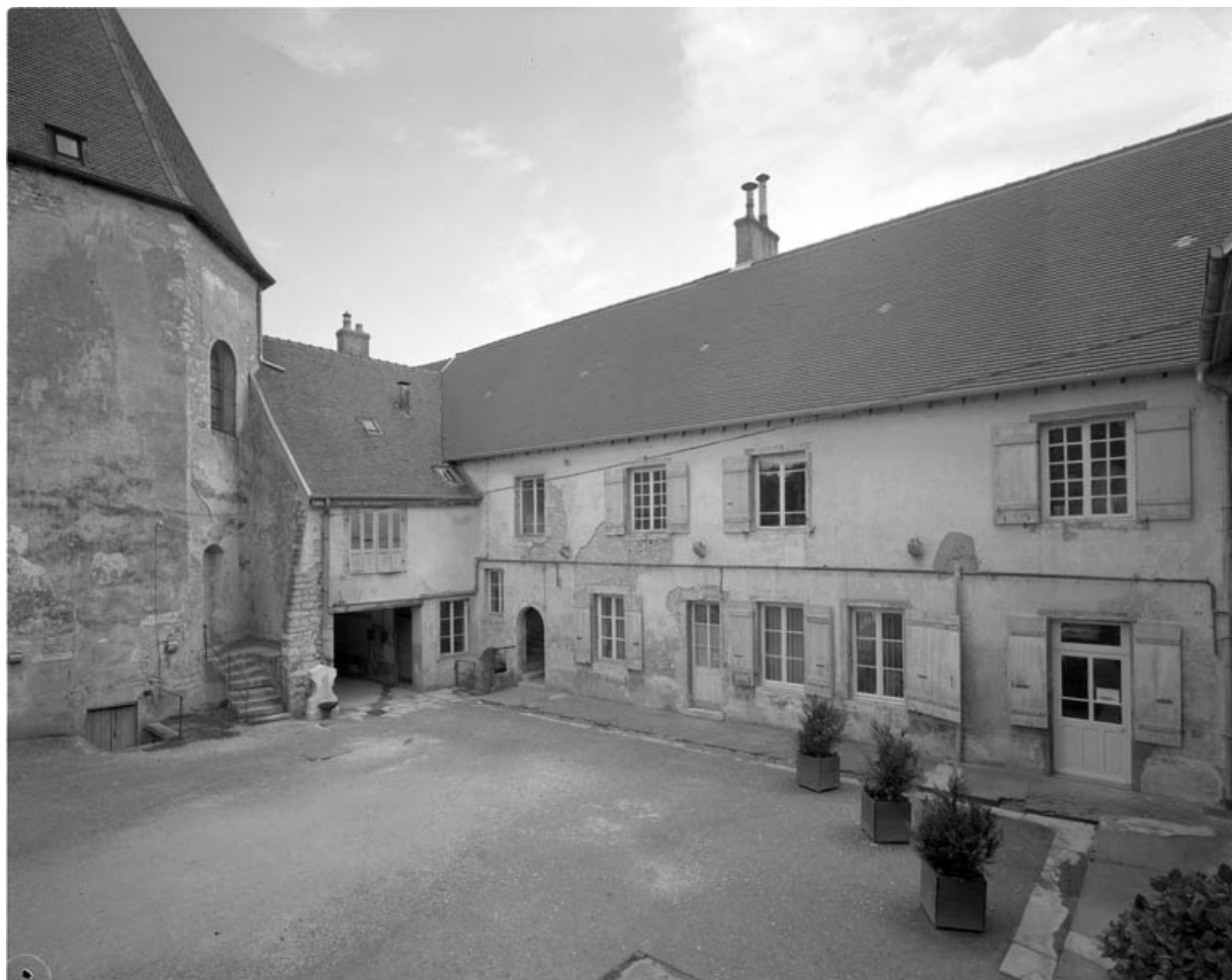
Bâtiment sur cour : aile gauche.
