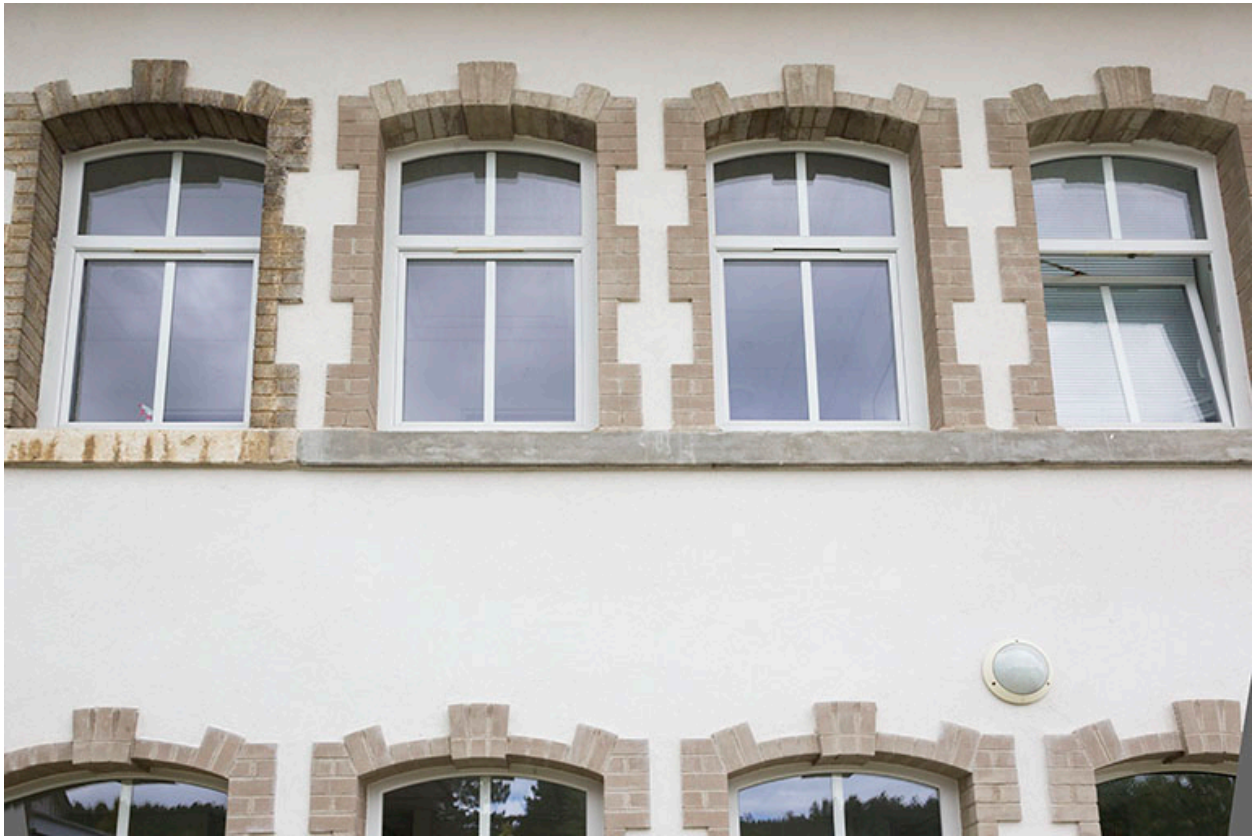
Atelier d'origine : fenêtres multiples (refaites) de l'étage, vues en contre-plongée.
