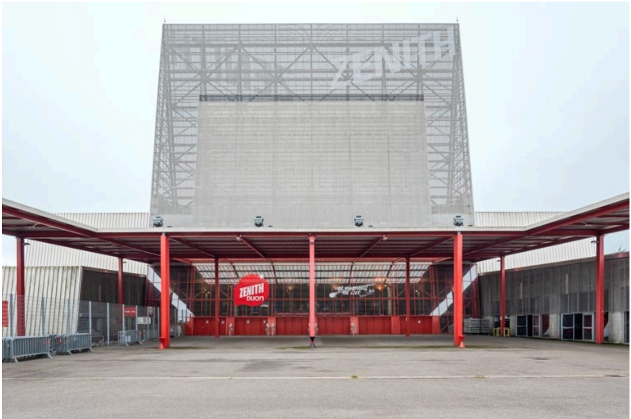
Corps principal, avec portiques et façade-écran.
