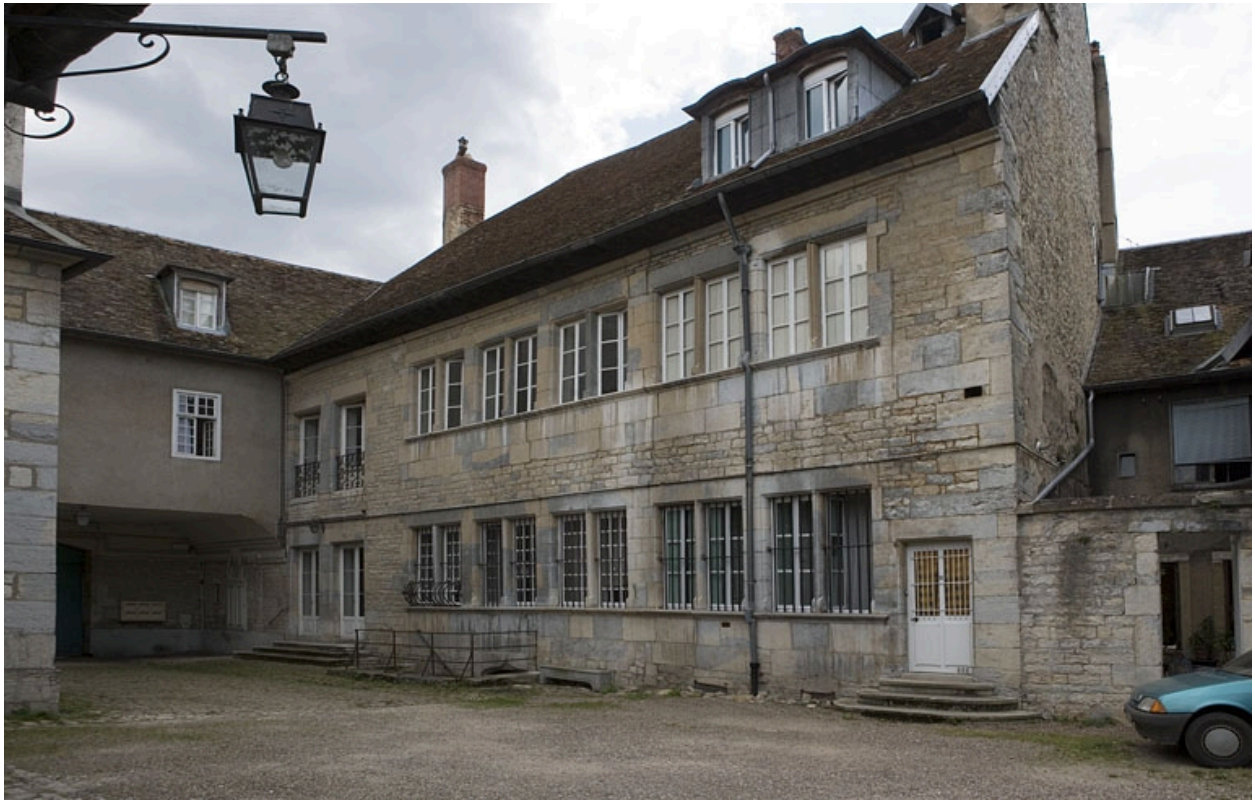
Vue d'ensemble d'ensemble du logis principal depuis le fond de la cour.
