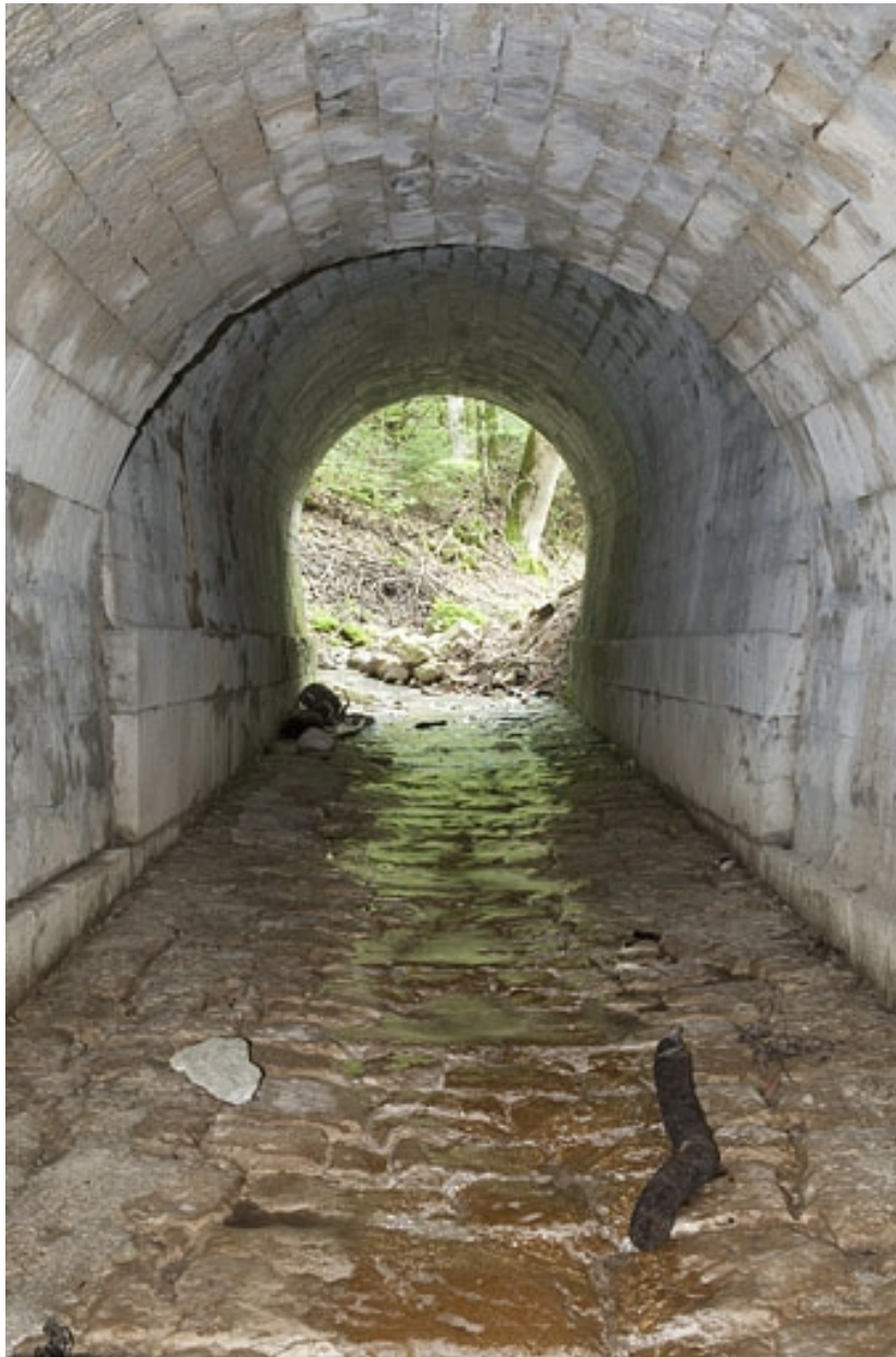
Intérieur du pont-aqueduc (n° 6) en direction des Tavins.
