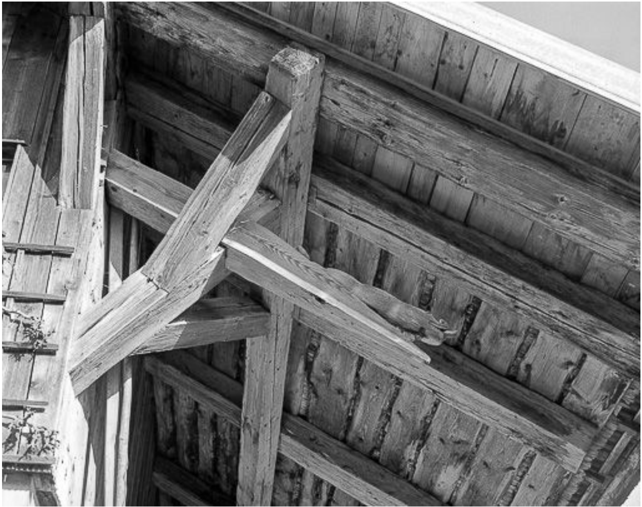
La ferme en 1976, arbalétriers côté nord : serpent (1er, à gauche).
