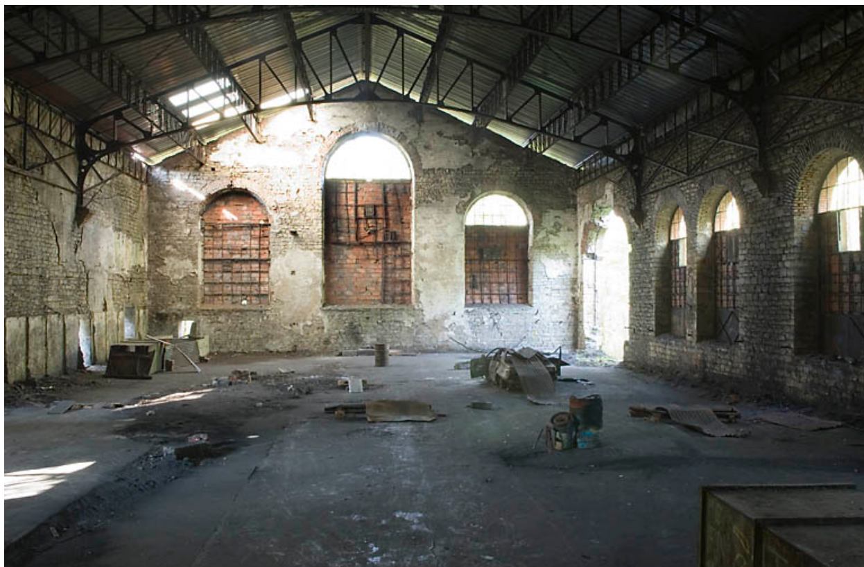
Vue d'ensemble du bâtiment des vestiaires.
