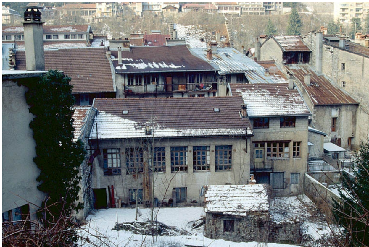
Façade postérieure des bâtiments sur cour.
