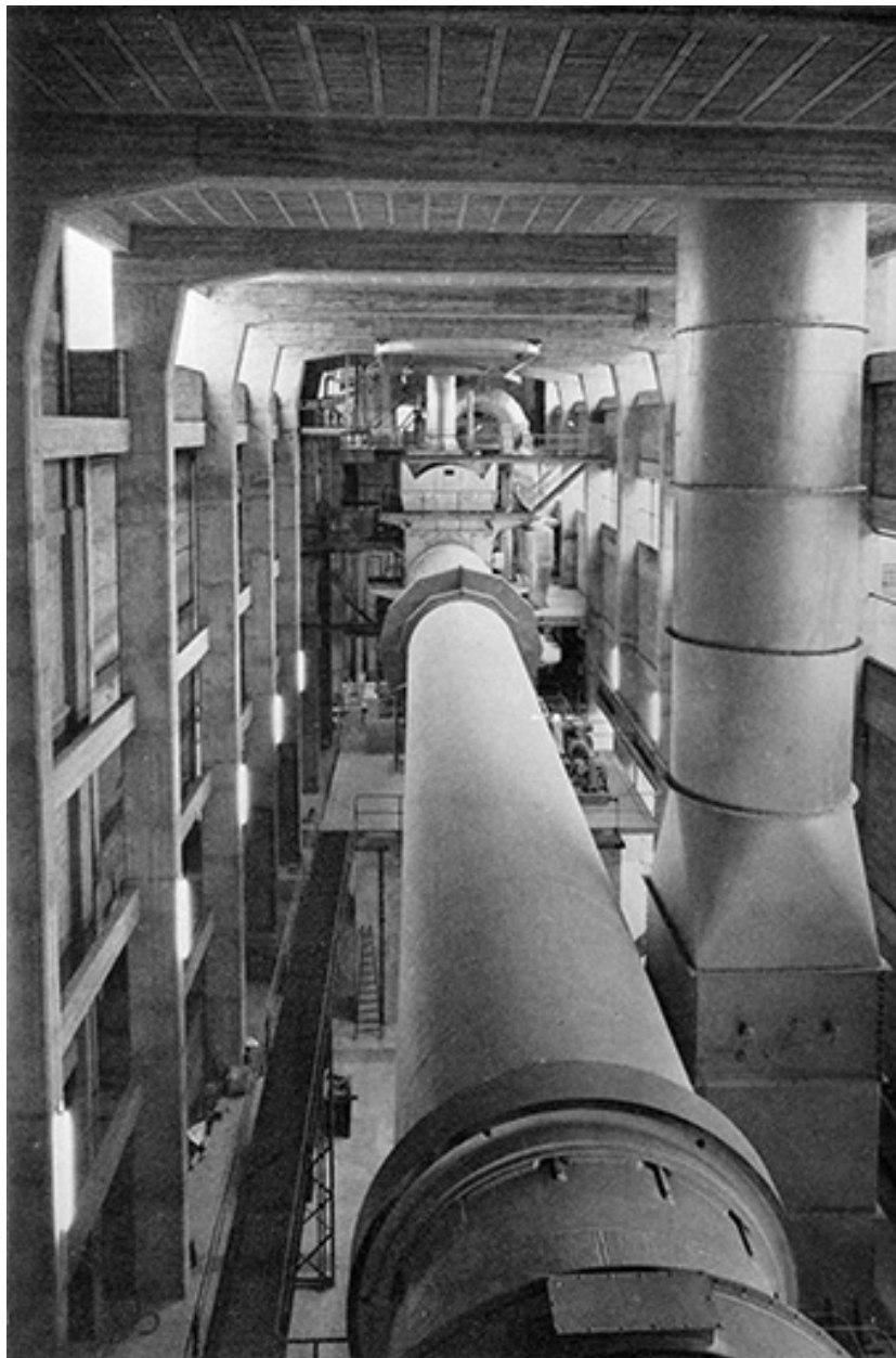
Vue d'ensemble du four rotatif.
