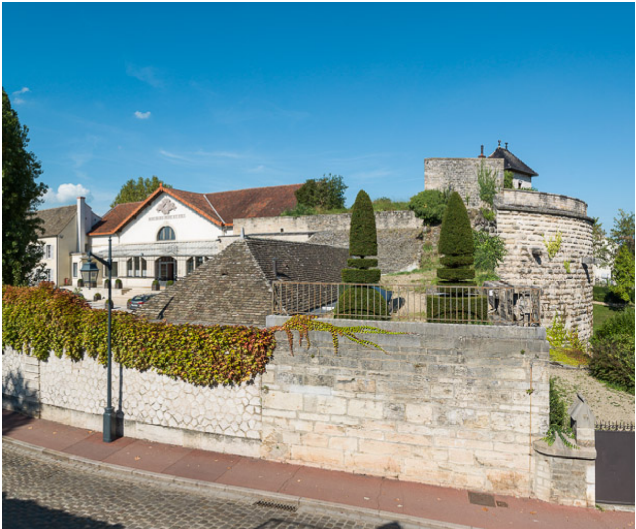
vestiges des remparts et rue du Château.
