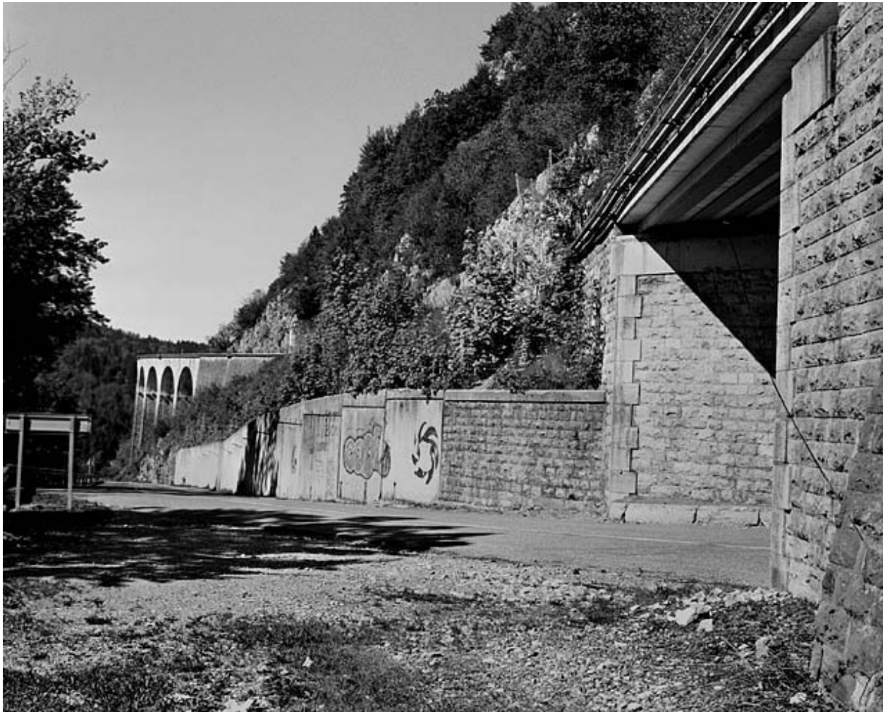
Elévation sud, de profil.
