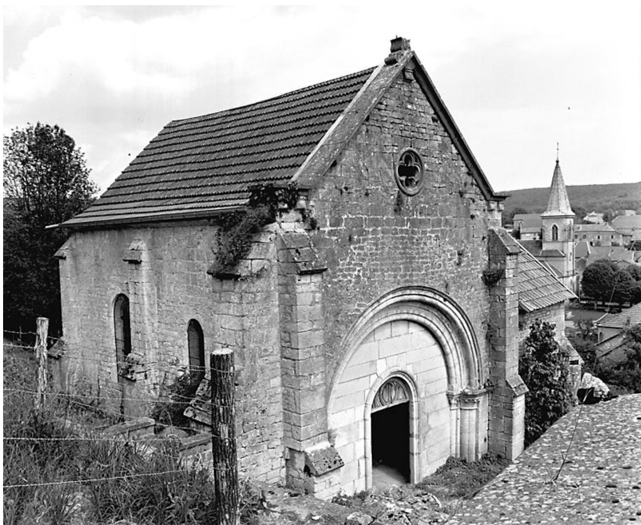
Façades antérieure et latérale gauche.
