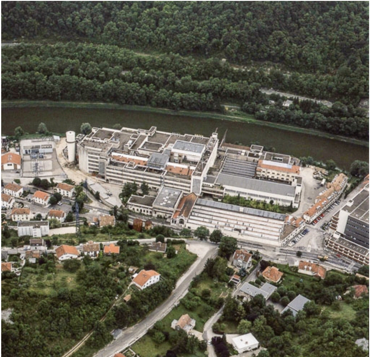
Vue aérienne de l'usine A, depuis le nord-est.
