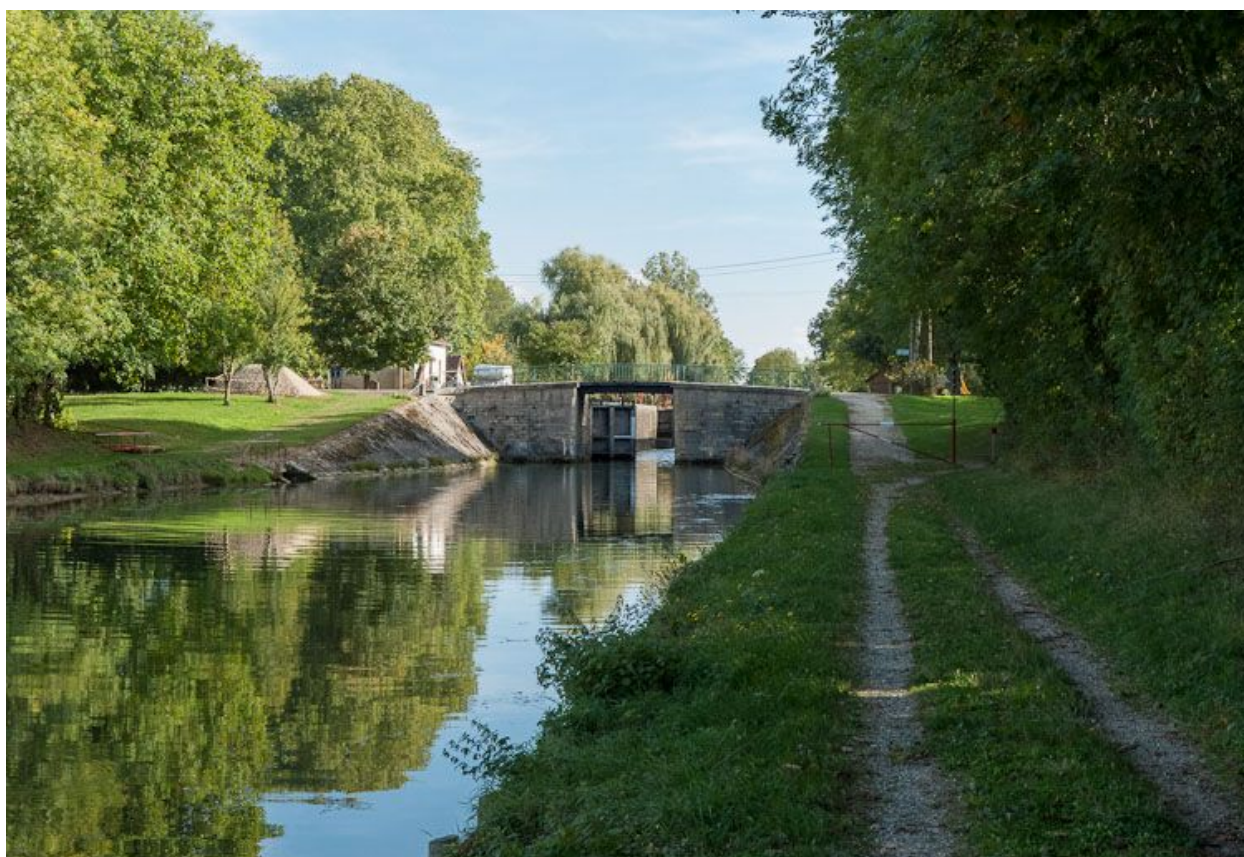
Le pont sur écluse vu d'aval.
