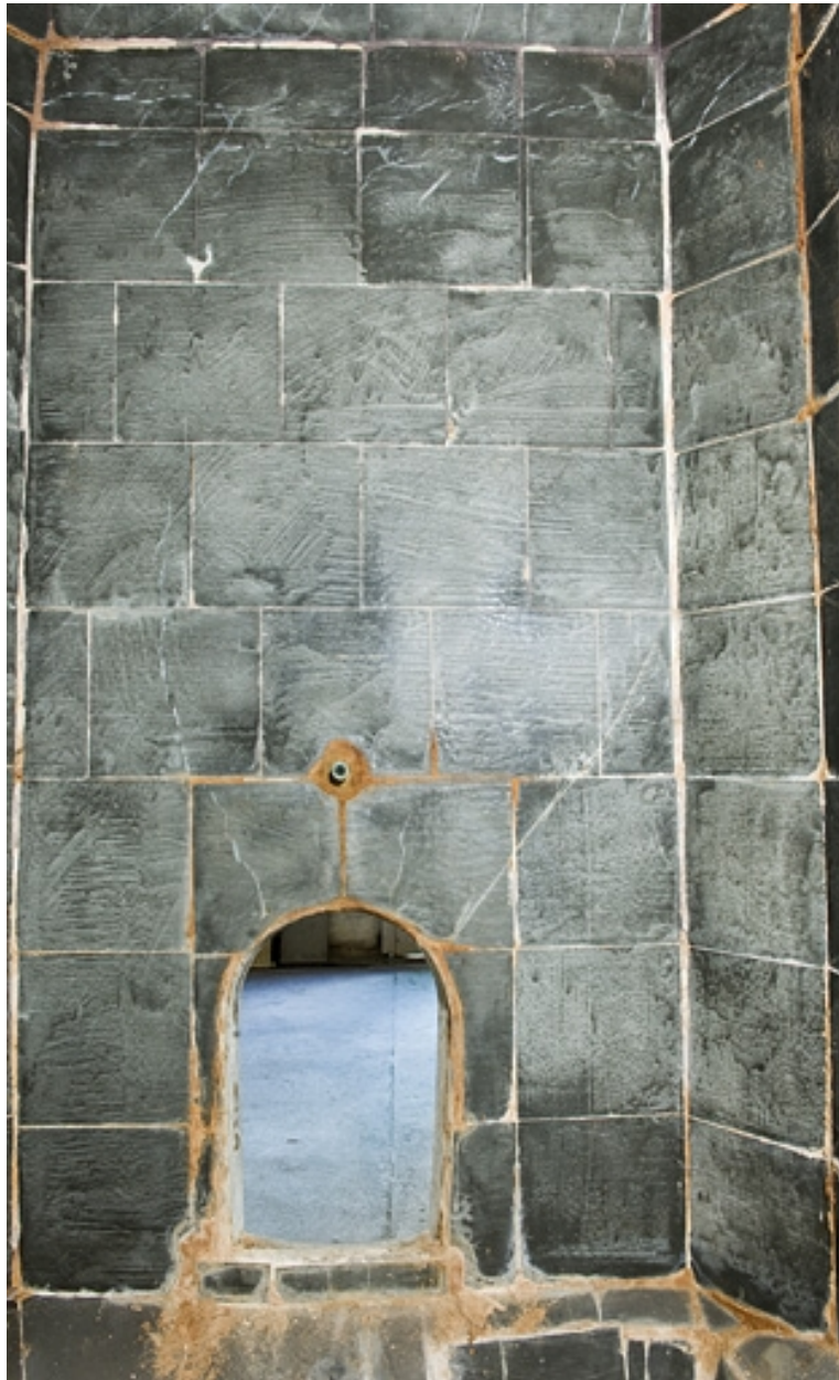
L'ouverture d'une cuve depuis l'intérieur.
