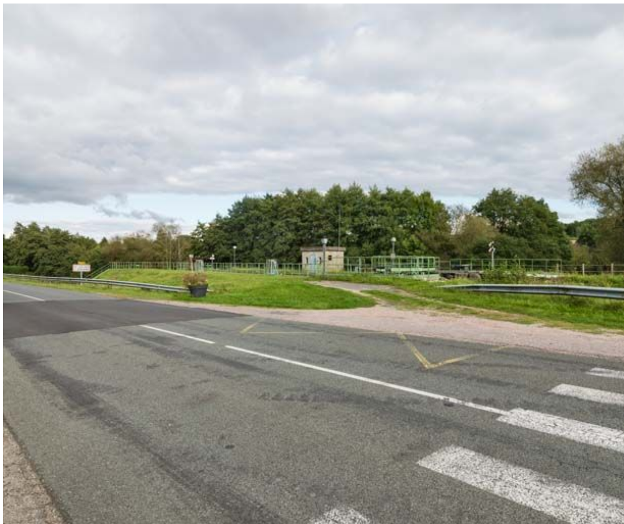
Vue d'ensemble du site d'écluse.
