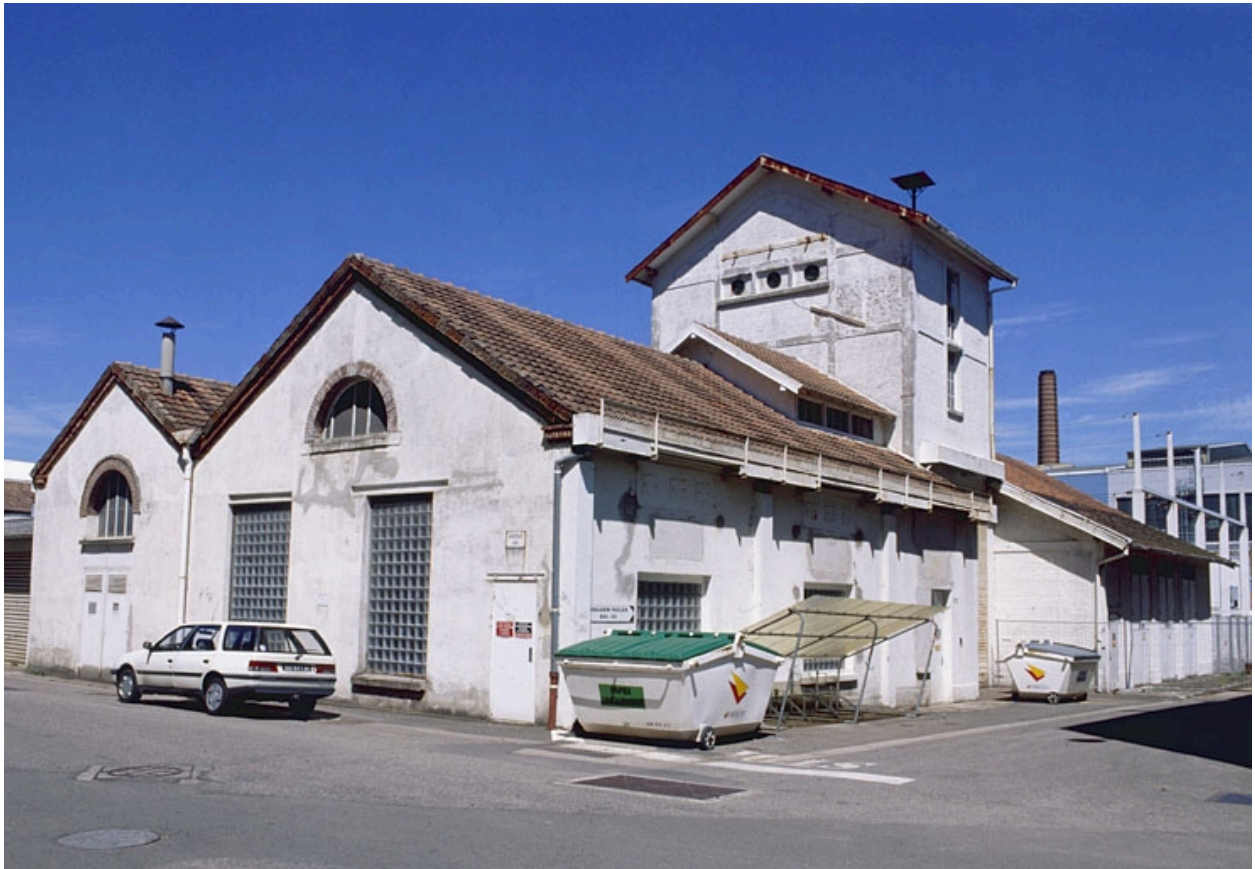
Station électrique et transformateur.
