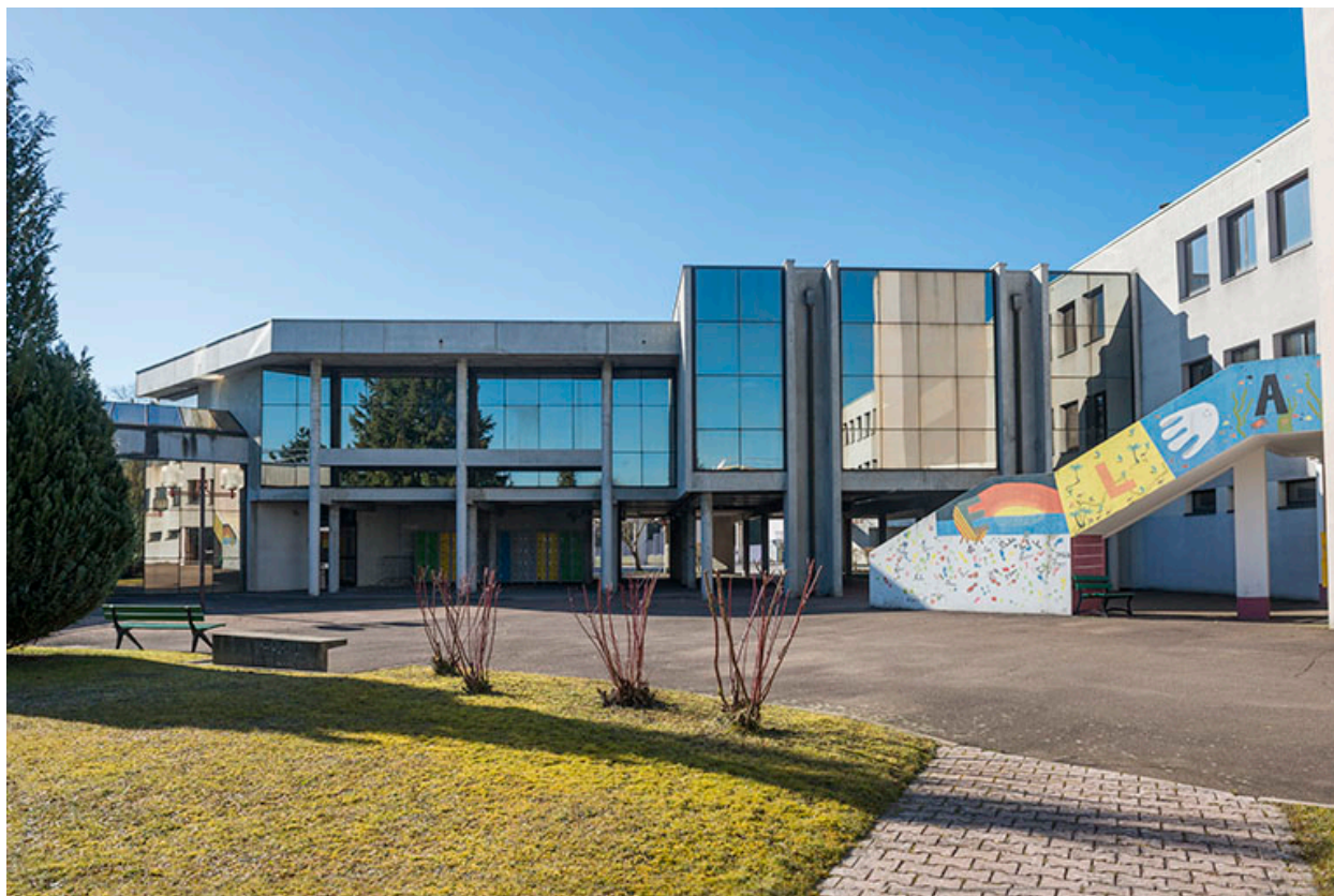
Façade nord du bâtiment d'accueil.
