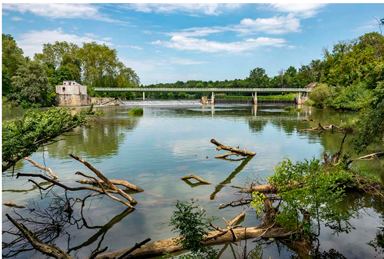
Vue générale depuis l'aval.
