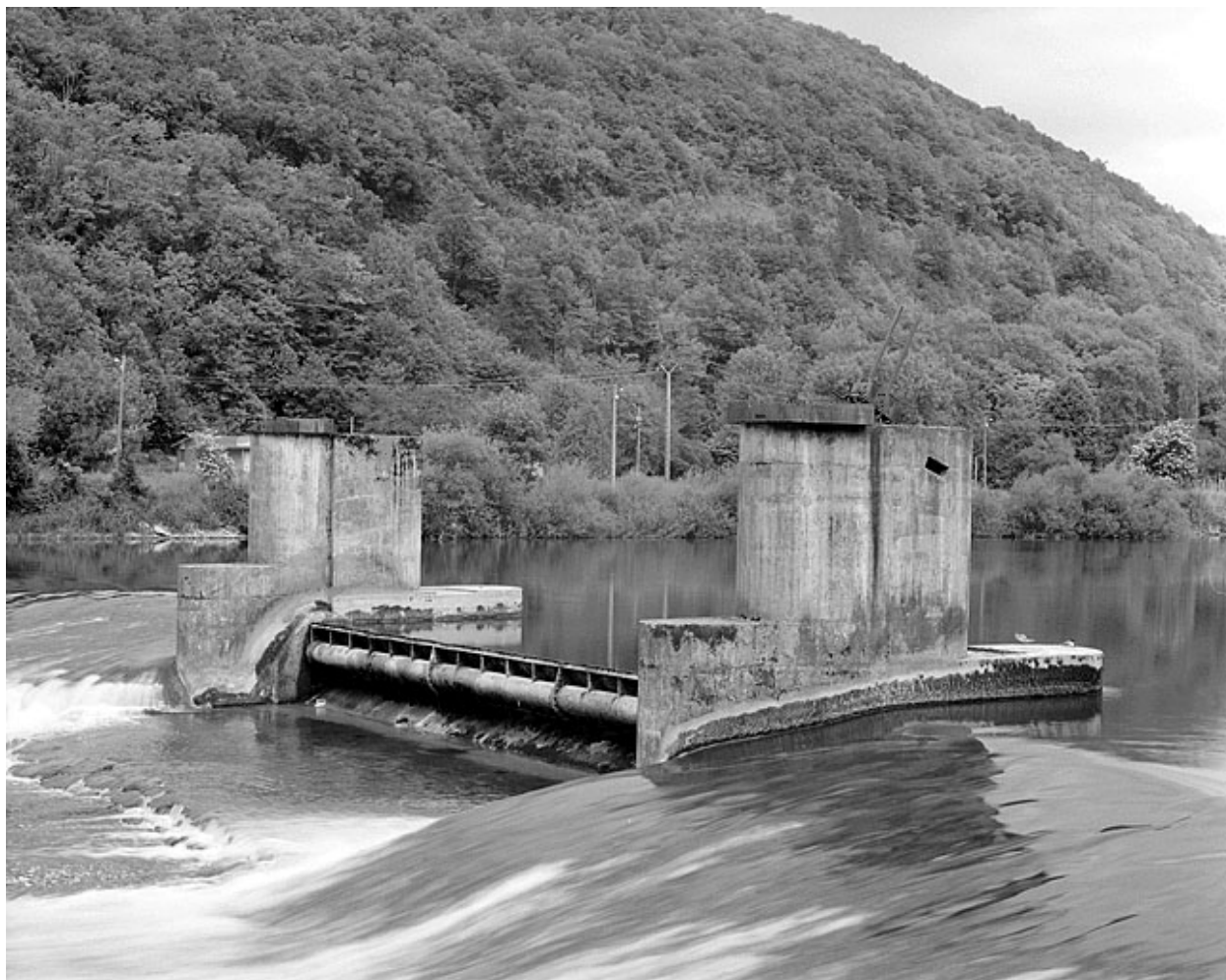
La vanne clapet.
