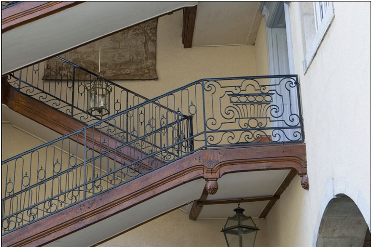
Détail de la rampe en fer forgé de l'escalier à cage ouverte.
