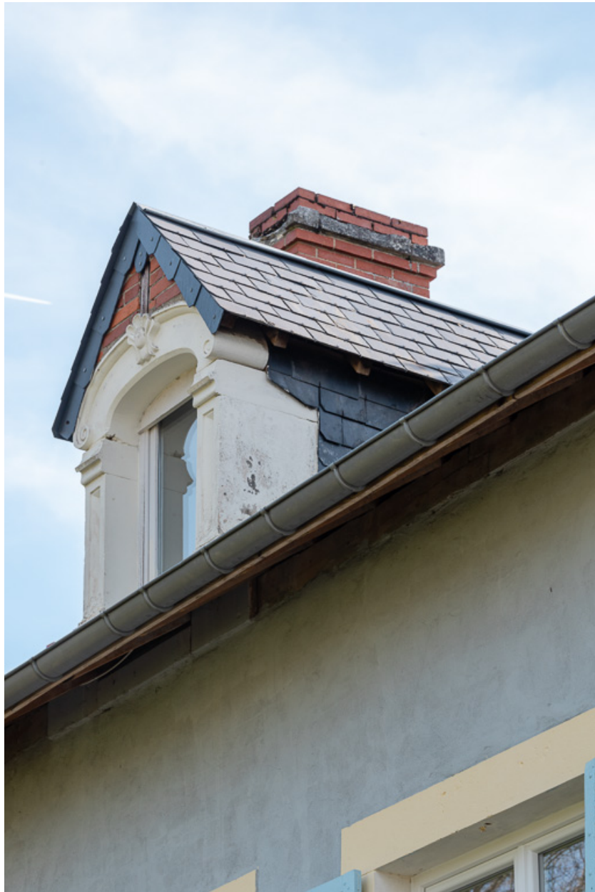
Lucarne de la façade nord-ouest.
