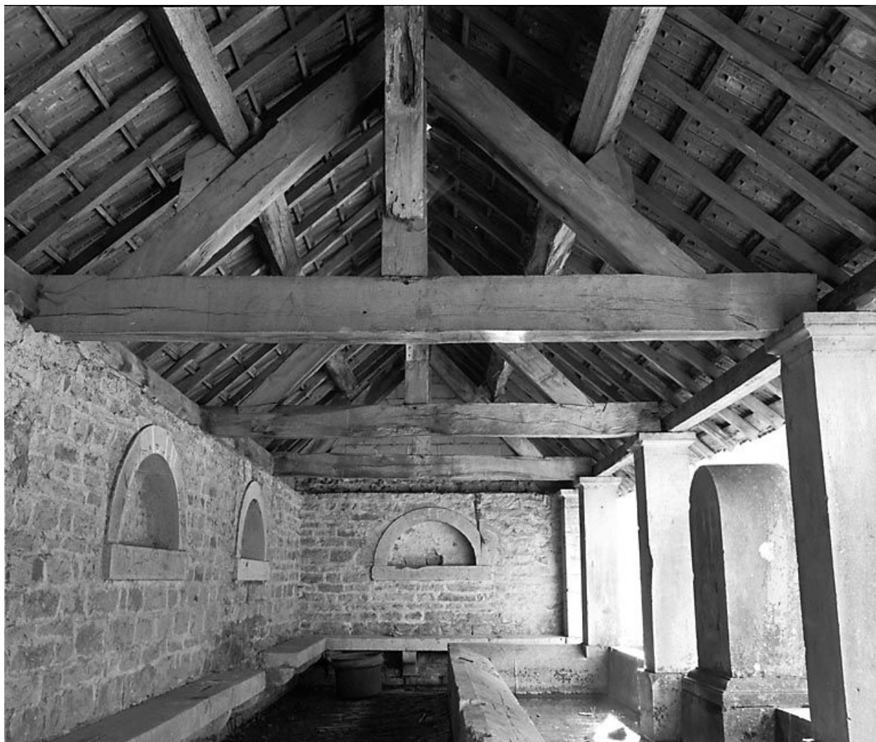
Intérieur : vue de trois quarts droit.
