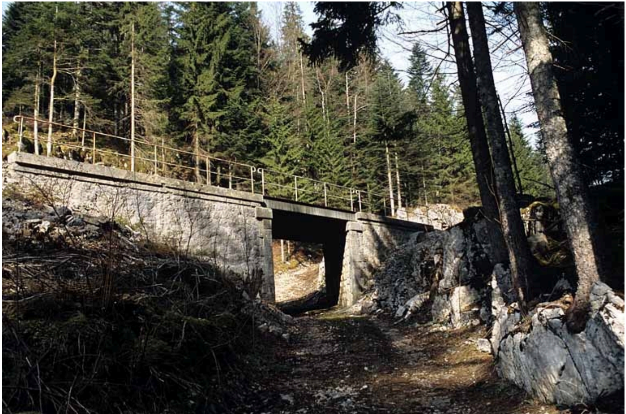
Vue d'ensemble, depuis le chemin à l'est.
