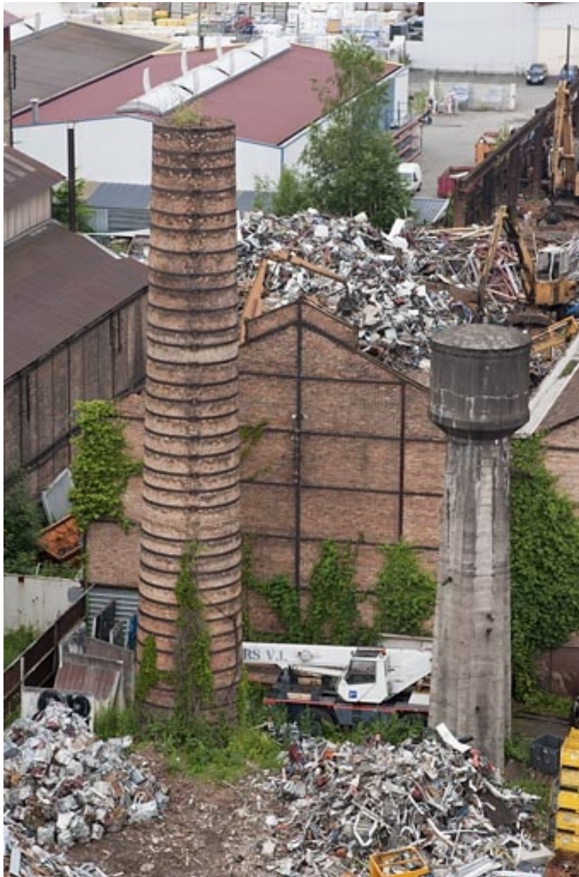
Cheminée et château d'eau.
