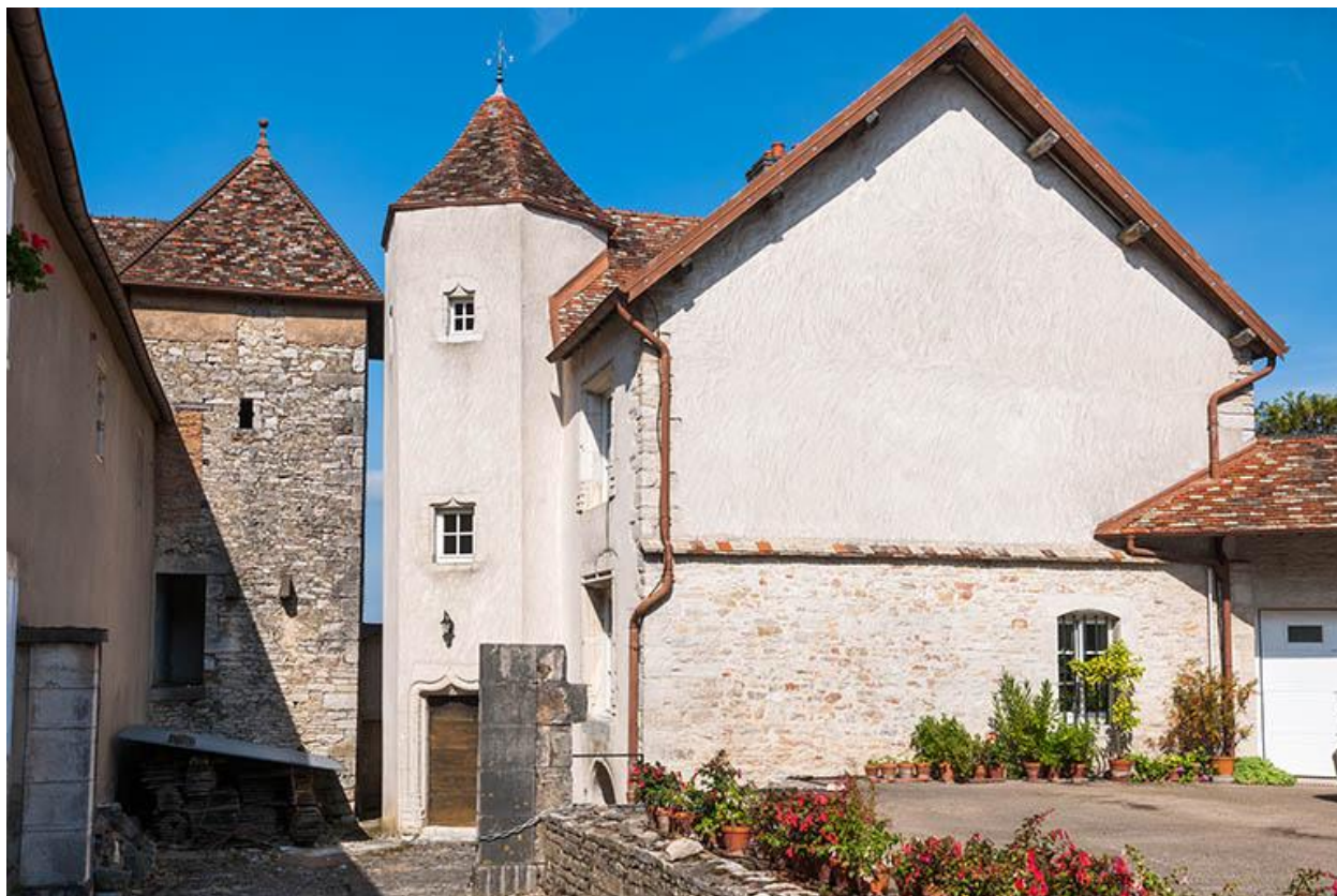
Ancienne maison située au nord-ouest
