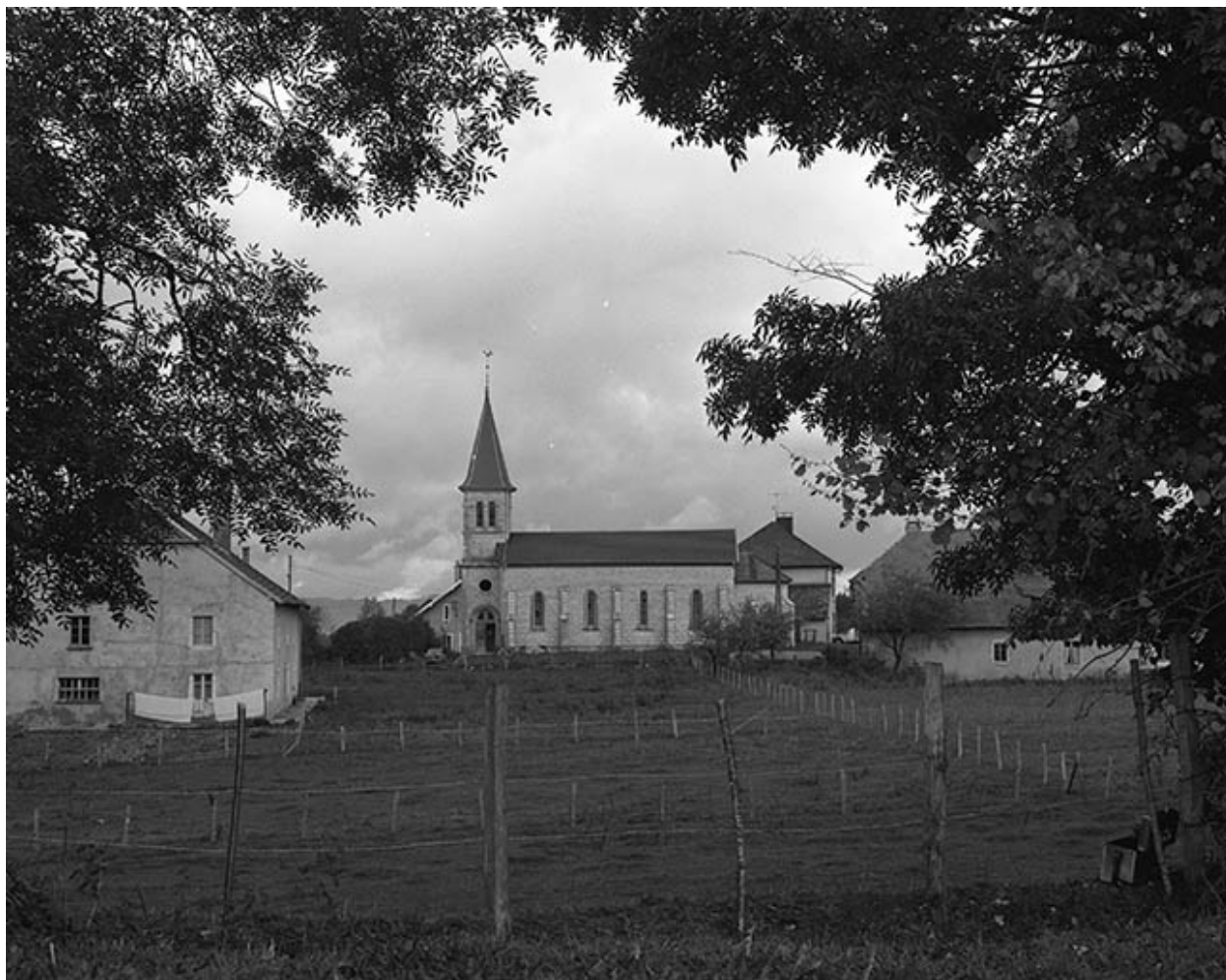
Façade latérale sud.
