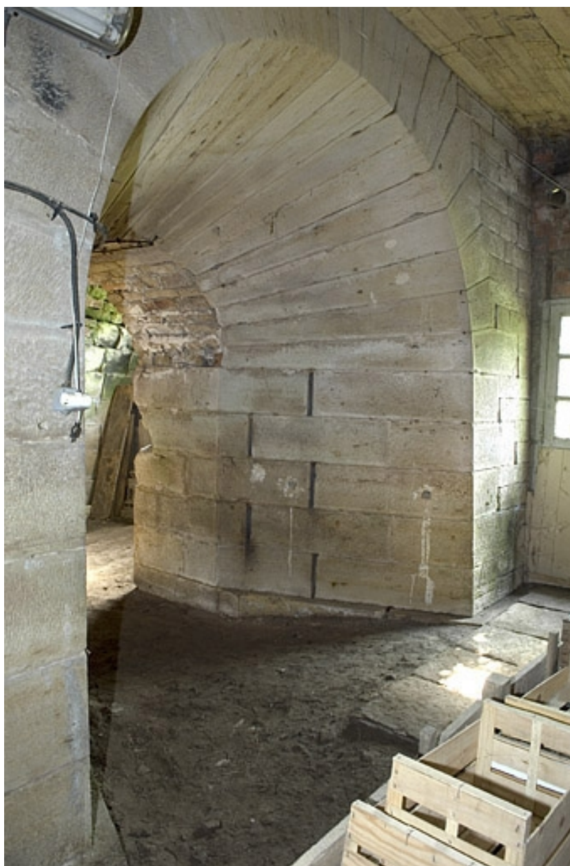
Détail d'une embrasure et de son appareillage.
